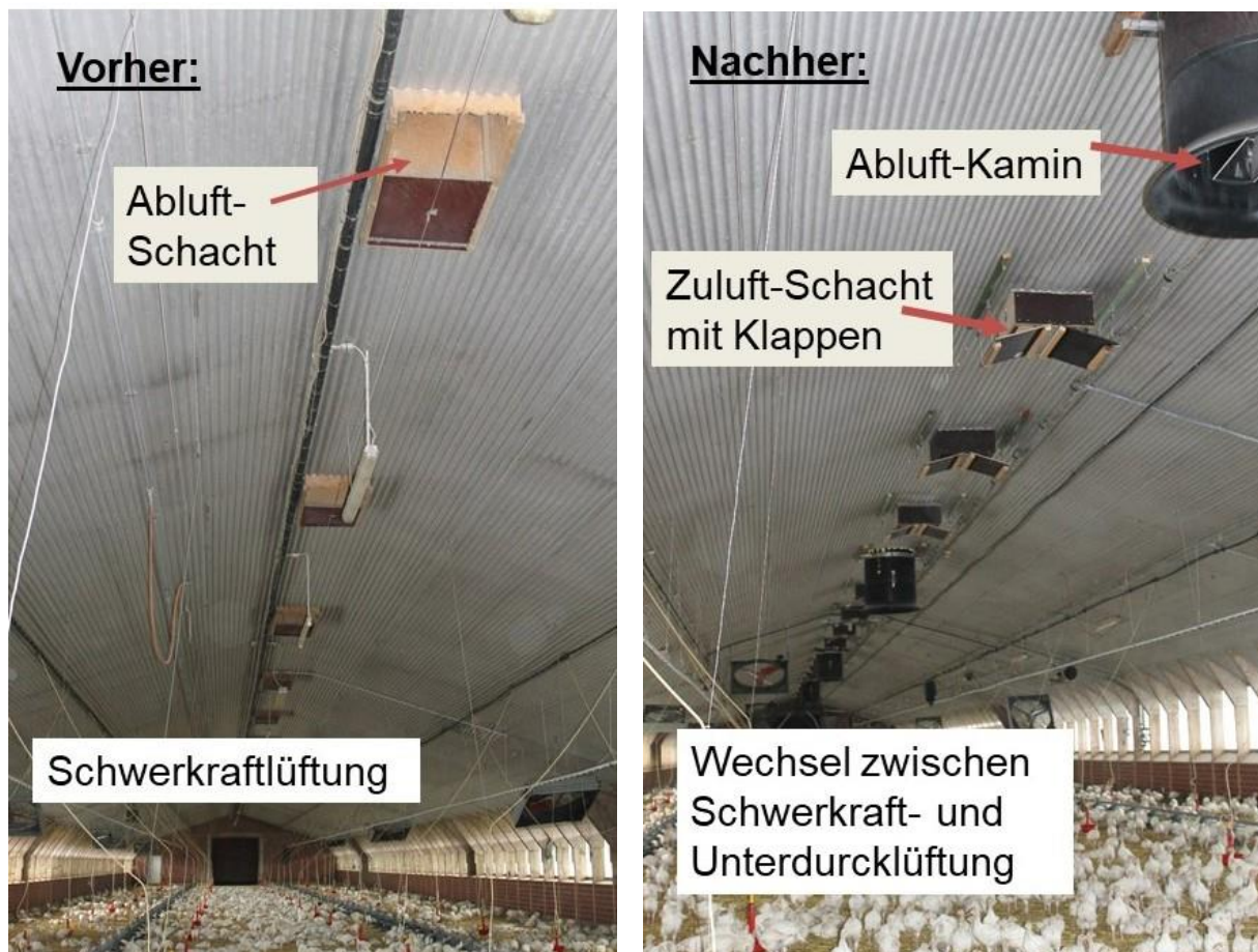
Abbildung 7: Umbaumaßnahmen an den Firstlüftungen
