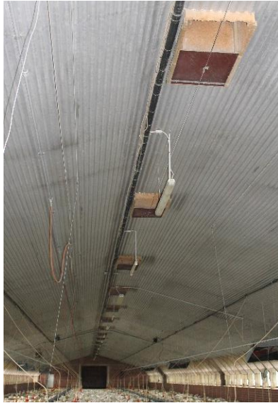
Abbildung 3: Offenstall mit geöffneten Firstöffnungen; Innenansicht
