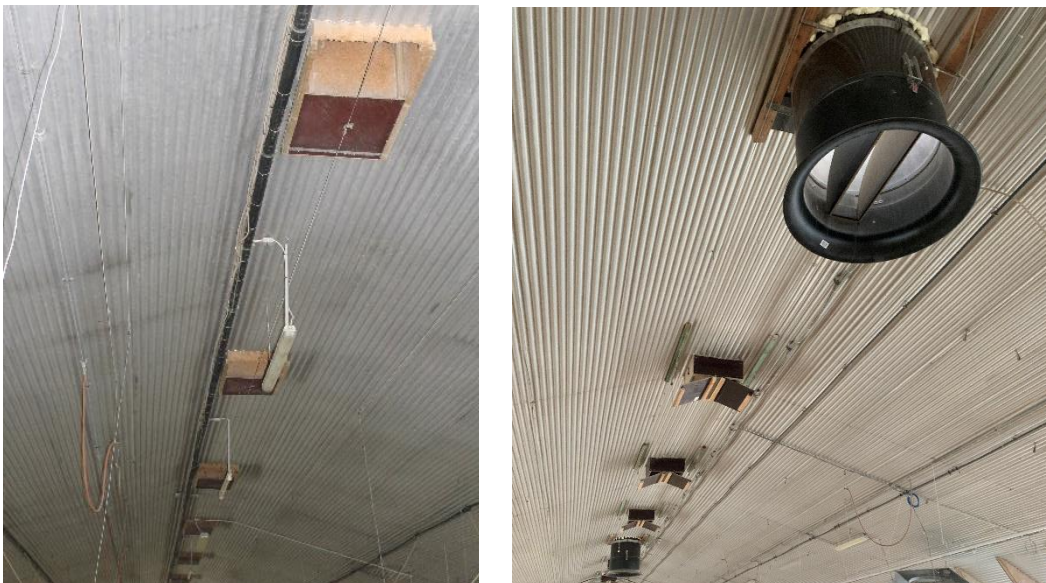
Abbildung 5: Links: Vor dem Umbau der Firstöffnungen. Rechts: Durch den Umbau wurden die Firstöffnungen durch regelbare Lüftungsklappen ergänzt, außerdem wurde ein Teil der Firstöffnungen durch Abluftschächte ersetzt.
